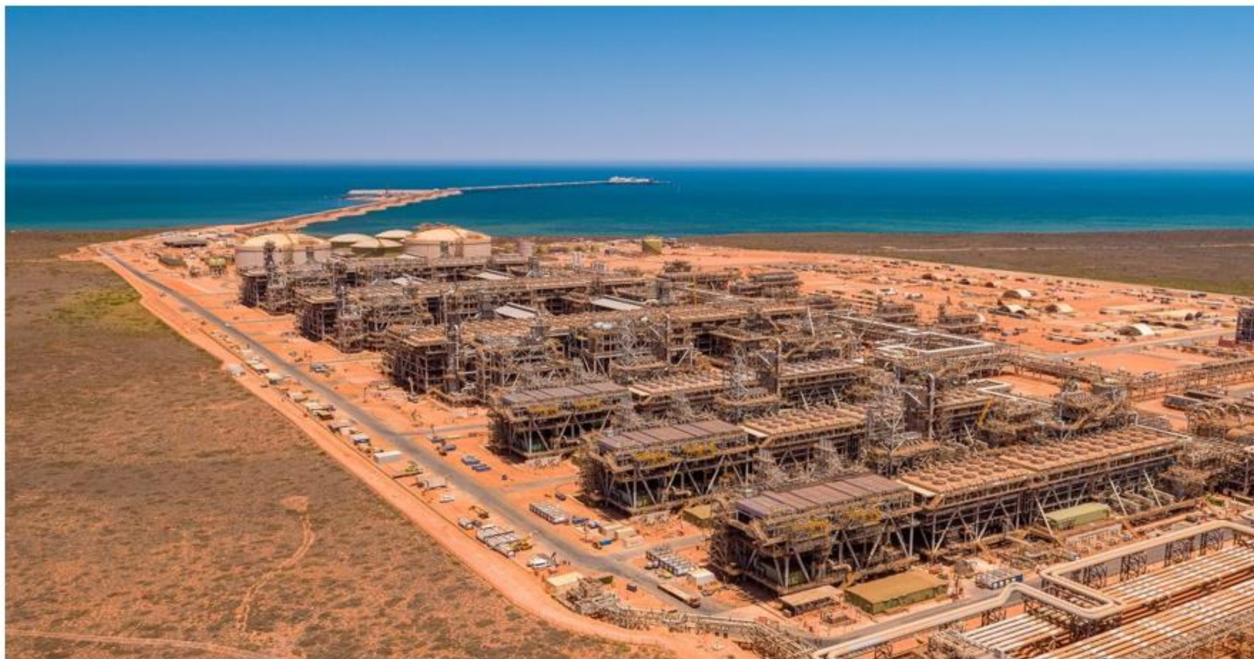
Foto: Gorgon projektet. LNG naturgasanlæg på den ubeboede ø, Barrow Island
